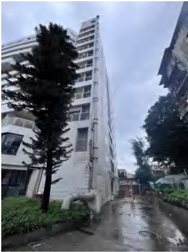
污水站臭气排放口
